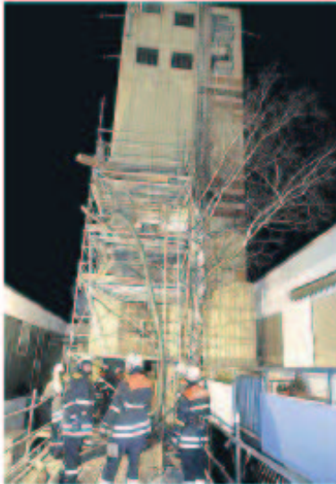
Seit Montag laufen Löscharbeiten am Silo. Foto: Rolf Ruppenthal
