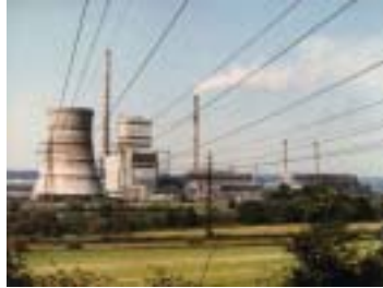
Mělník III Thermal Power Station, with a 500 MW turboset (1981)
