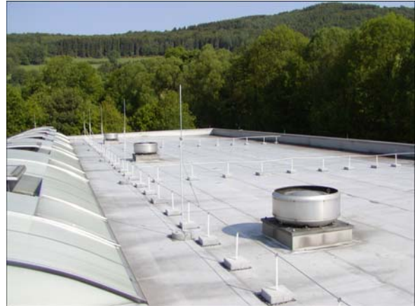
Bild 6: Eine höherliegende Fangeinrichtung
