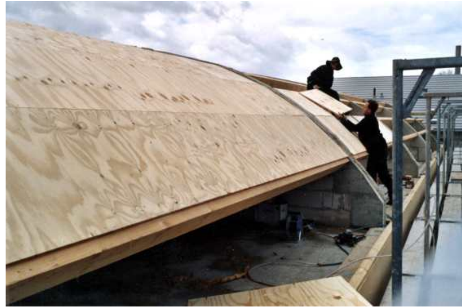
Arbeiten an der Dachkonstruktion
