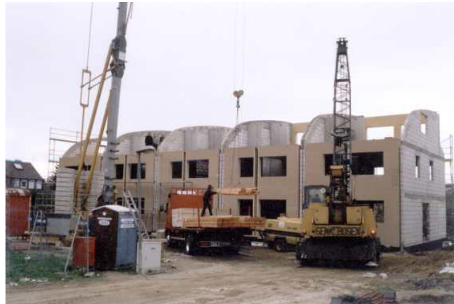
Die im Rohbau fertiggestellte Nordfassade
