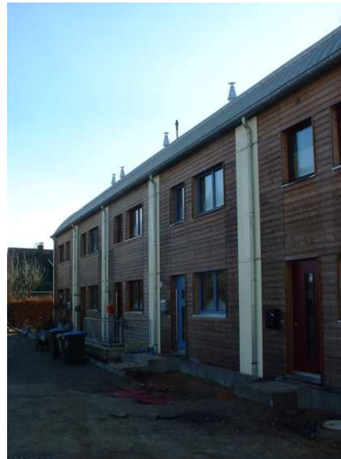
Nordfassade des fertiggestellten Gebäudes
