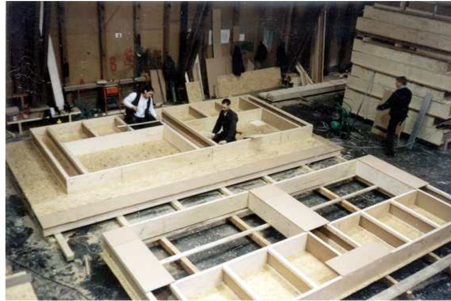
Vorfertigung der Holzrahmen-Elemente in der Zimmerei Wölbeling
