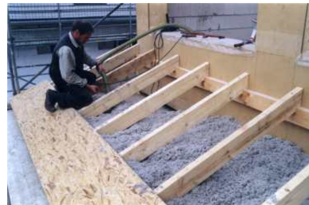
Einbringen der Zellulosedämmung aus recycletem Altpapier
