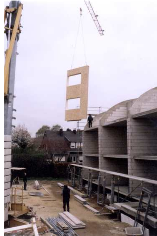
Montage der Holzelemente zwischen den massiven Schotten
