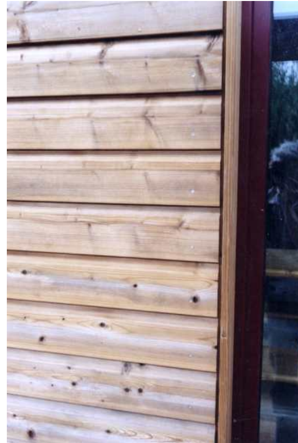
Detail der Thermoholz* - Stülpchalung
